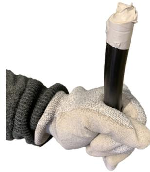
2. Enfiler le câble dans la gaine jusqu'à l'armoire, au poteau, ou la limite du domaine privé.
