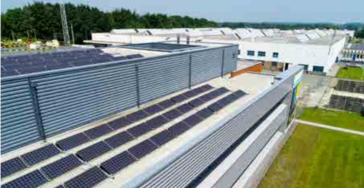
GEBÄUDE DES NEUEN TECHNIKZENTRUMS IN STRÉPY-BRACQUEGNIES
