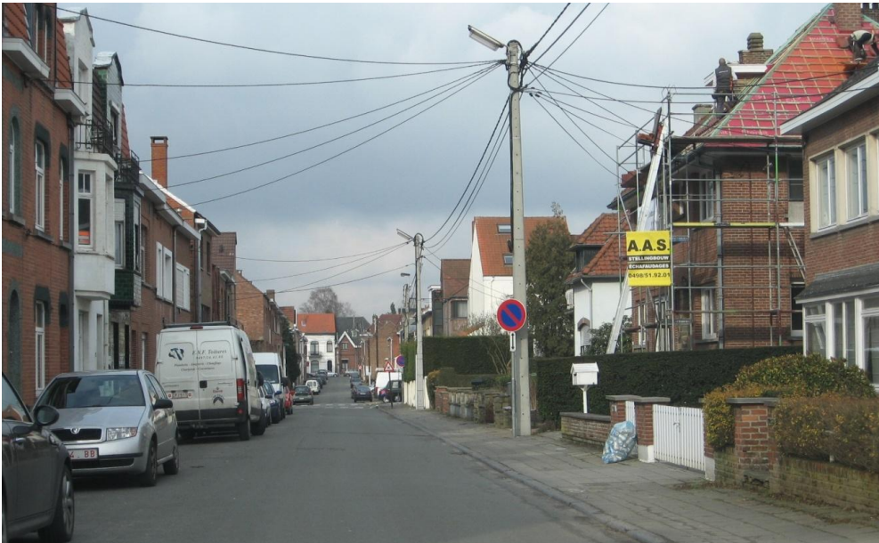
Après les travaux de mise en souterrain
