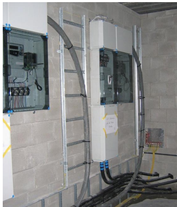
Compteurs BT (haute puissance)
