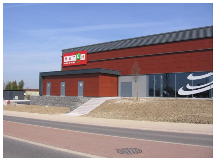
Cabines clients Match/Lunchgarden/EKZ à Eupen (trois cabines séparées dans un bâtiment)
